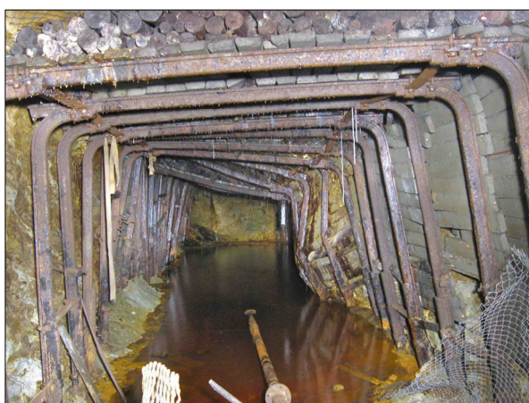
Porucha ve spojovací chodbě -1106- na štole Mír se od r.1986 do r.2005 také příliš nezměnila
