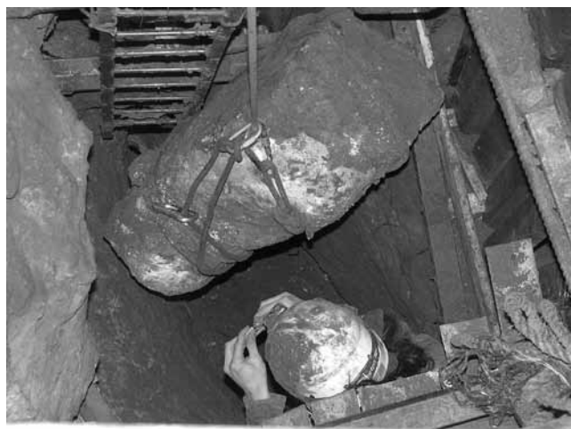
Foto 3 Odstraňování balvanů (Foto J. Tošner) Photo 3 Removal of boulders (Photo by J. Tošner)
