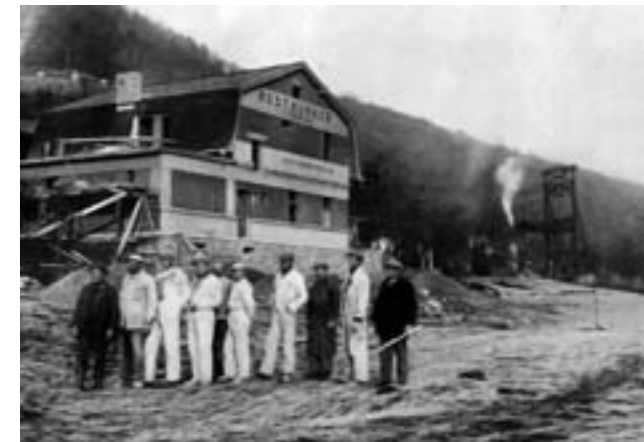
Stavba restaurace U Nádraží. Zcela vlevo majitel Vojtěch Hulan, 1932. Foto archiv Jaroslava Kasíka
